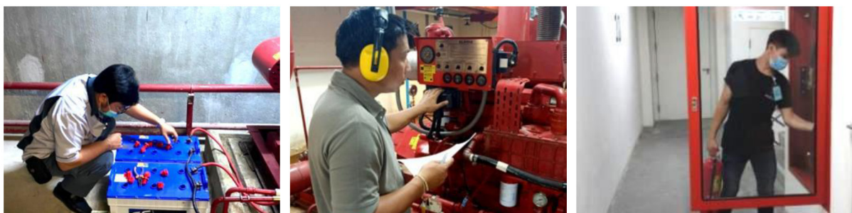
ภาพที่ 3-4 ตรวจสอบระบบสัญญาณแจ้งเหตุเพลิงไหม้
